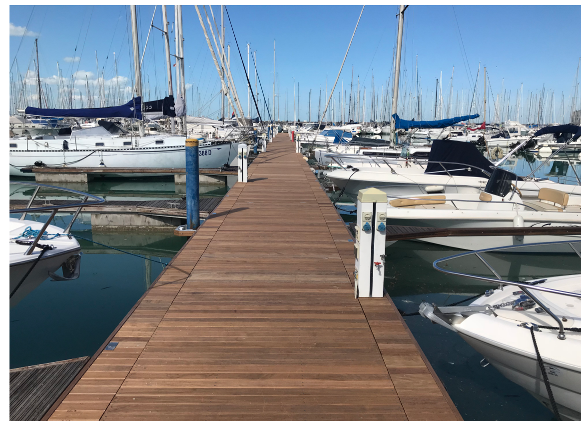
Pontili Saturno CS con galleggianti in calcestruzzo e piano di calpestio in legno esotico.
