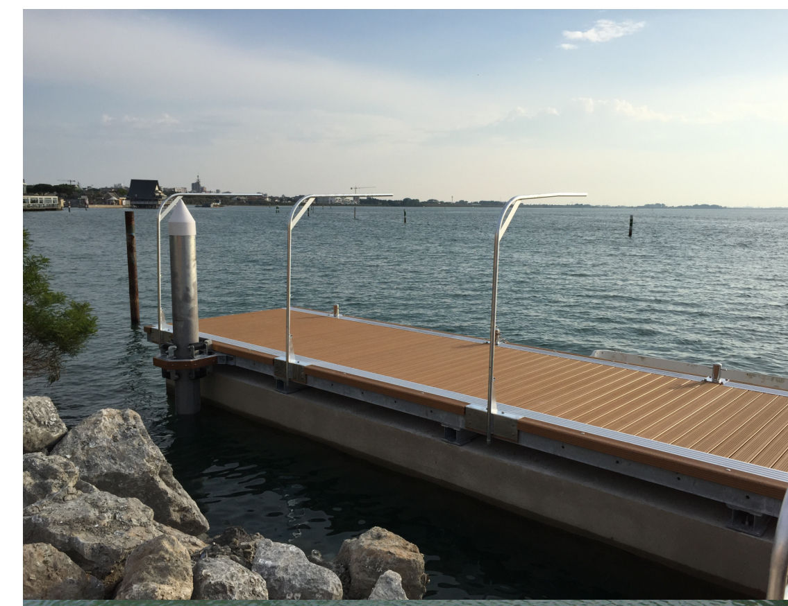
Pontili Saturno CS con galleggianti in calcestruzzo e piano di calpestio in legno esotico.
