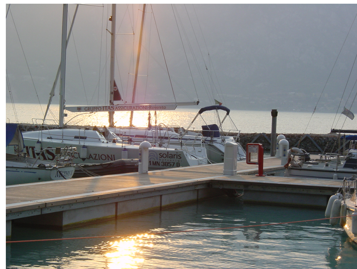
Pontili Saturno CS con galleggianti in calcestruzzo e piano di calpestio in legno esotico.
